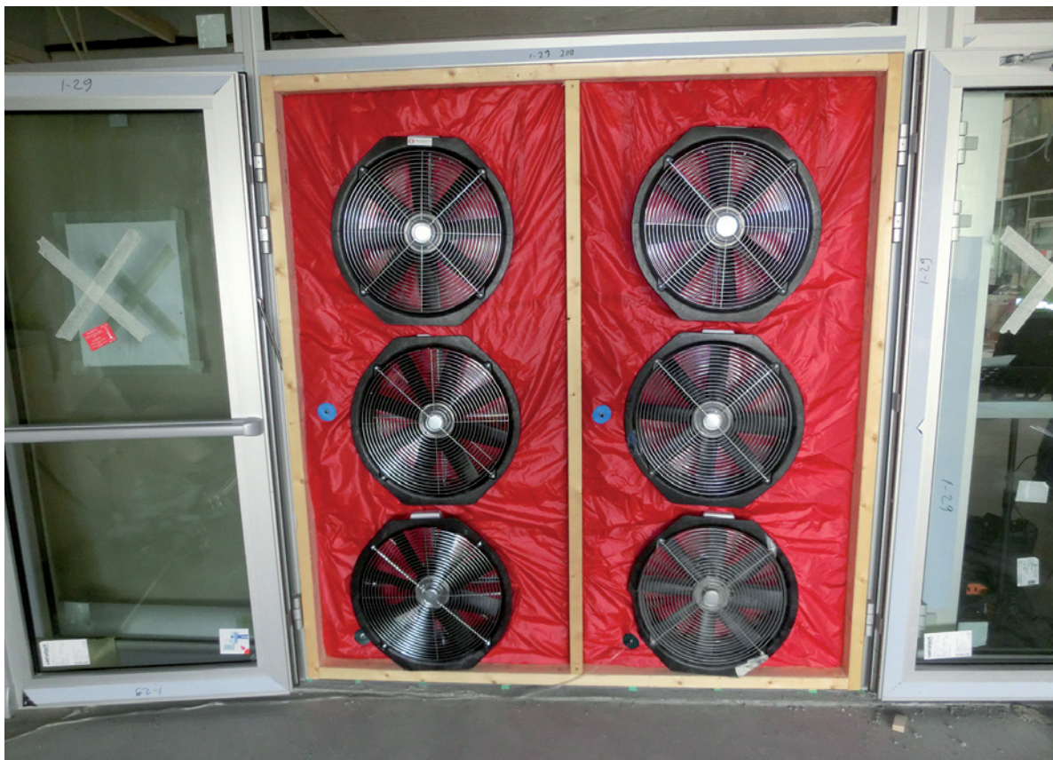
Figur 2.2: "Blower Door" montert i døråpning. Foto: Omega Termografering AS.
