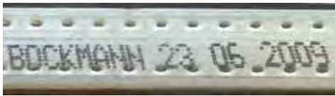
Bilde 2: Bildet av denne avstandslisten viser at vinduet/isolerglasset er produsert 23.6.2009.
