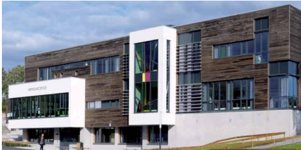
Figur B.1: Vestfasaden på Nøkkeland Skole i Moss er benyttet som illustrasjon på detaljert kuldebroregnskap for vinduer.
